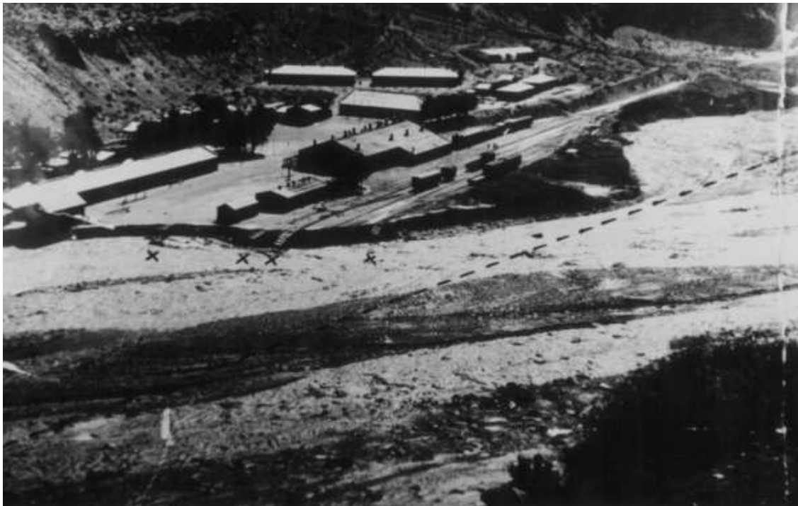
Figura 20 "Zanjón Amarillo después de 1934" 48
