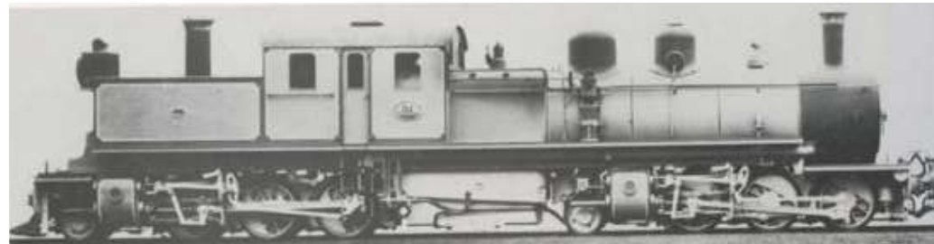
Arriba: La primera Kitson Meyer fue esta 0-6-0+0-6-0 para la Anglo Chilean Nitrate Railway. Abajo: La que hizo Beyer Peacock, una 2-6-0+2-6-0 que resultó exitosa. Más abajo: La gigantesca 2-8-0+0-8-2 colombiana fue el último diseño para este país, pero no pudo igualar el buen servicio que dieron sus antecesoras.
