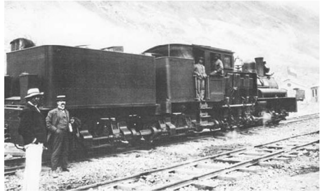
Los tres bogies motrices de la Shay le daban un excelente poder de tracción pero su velocidad no pasaba los 30 km/h.
